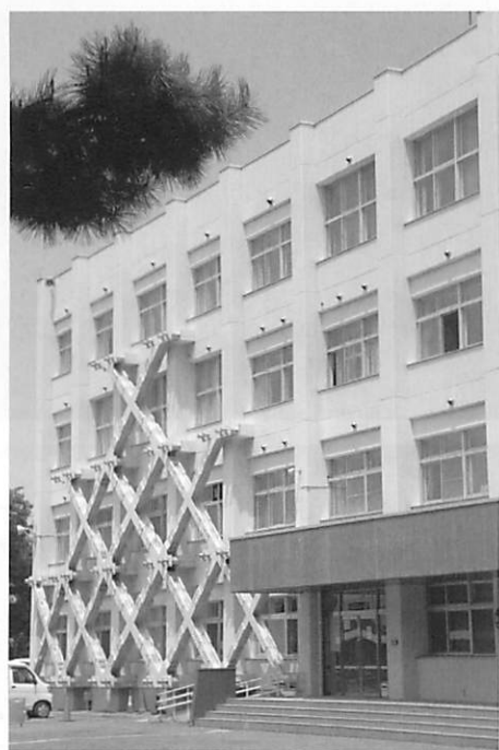
耐震補強工事後の校舎
