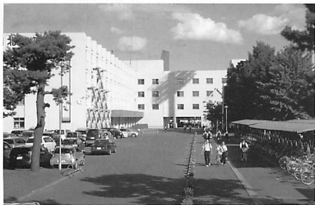
平成12年耐震補強工事後
